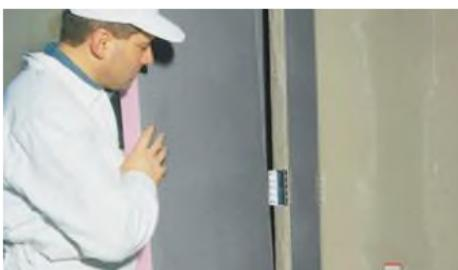
Montirani spojni element omogućuje vam da ploču **Austrotherm UNIPLATTE** bez dodatnih problema spojite s prethodnom.
