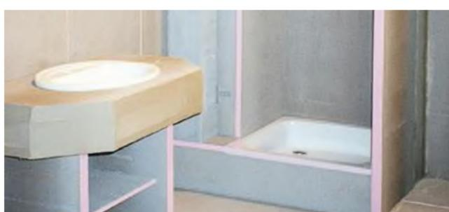
Pregradni elementi pri izgradnji tuš kabine: **Astrotherm UNIPLATTE®** nudi optimalnu podlogu za lijepljenje keramičkih pločica
