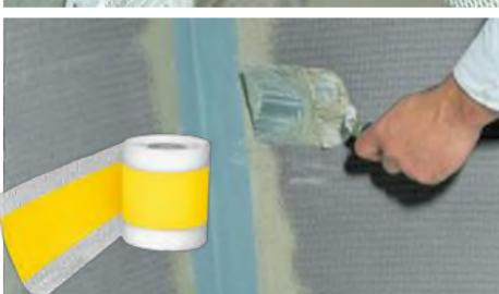
Preko "brtvene trake" (Murexin DB 70) izravnajte površinu ljepilnom masom. Podloga postaje idealno glatka i njezina priprema je završena!
