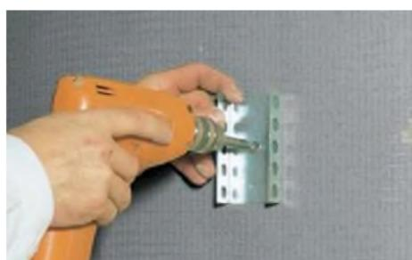
Kod izrade pregradnih zidova, obloga za kade itd. koriste se spojni elementi koji se pričvršćuju vijcima na zid ili pod.
