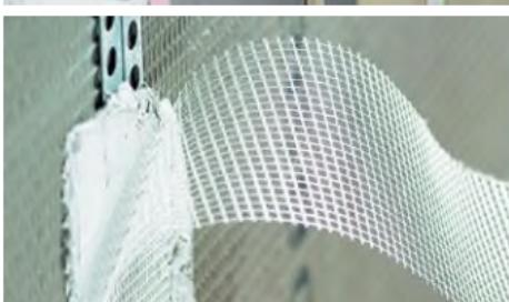
Staklenom tekstilnom mrežicom "zatvara" se spoj dviju ploča.
