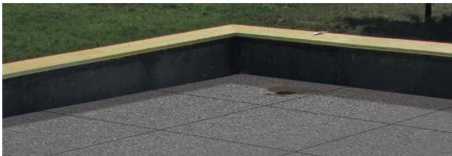
Ravni krovovi moraju biti projektirani s nagibom. To se može izvesti ili potkonstrukcijom (ploasti kosi beton) ili pomoću kosog krova Austrotherm EPS® W30-PLUS preko izolacijske plohe ravnog krova Austrotherm Resolution®.
