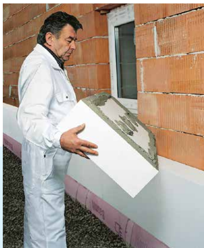
toplotno-izolacioni sistem na fasadnom zidu (tzv. "demit-fasada")
